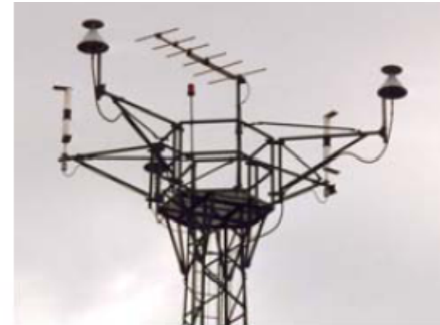
Fotografía con varias antenas Discono y una antena Yagi en
